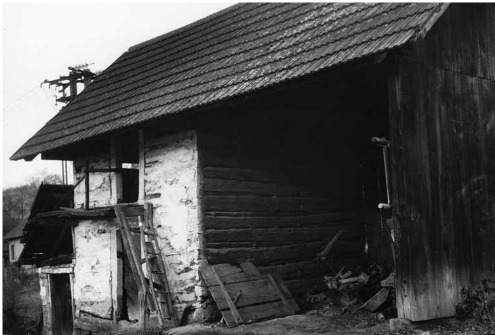
Březnice čp. 21, roubená komora se sklípkem
