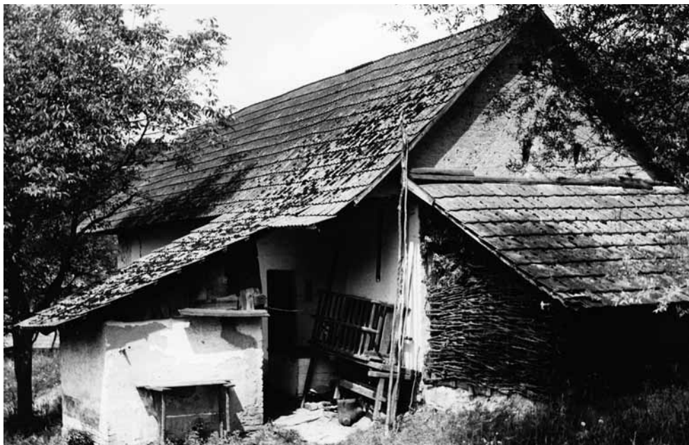
Březnice čp. 21, výměnkářské stavení s kolnou s vyplétanou stěnou, nešetrně odstraněné pro novou výstavbu (archiv autorky)
