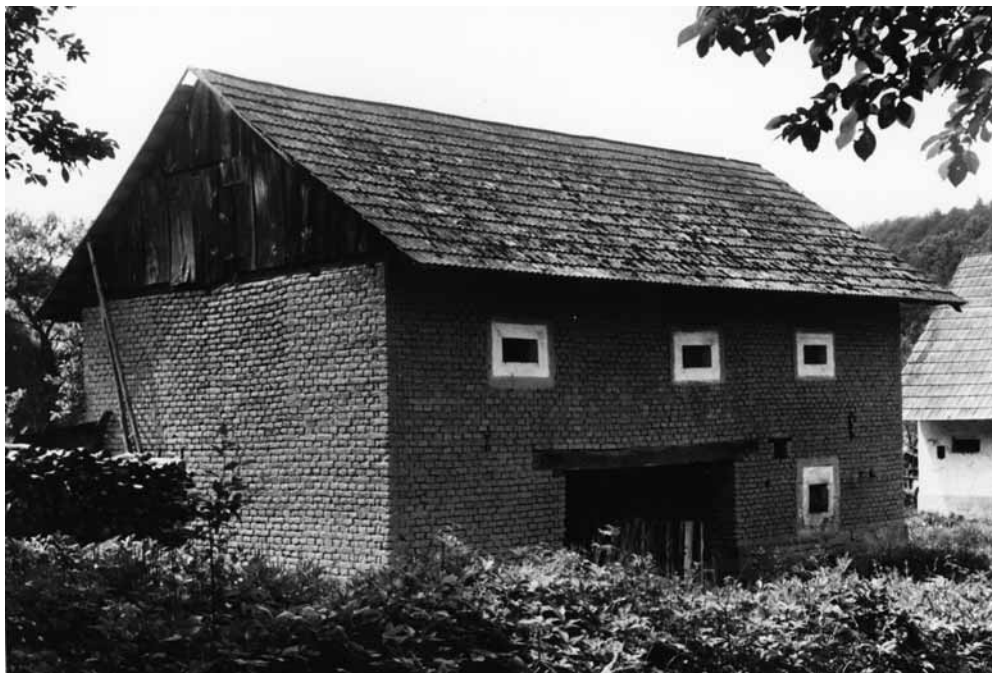
Březnice čp. 21, komora vybudovaná z nepálených cihel
