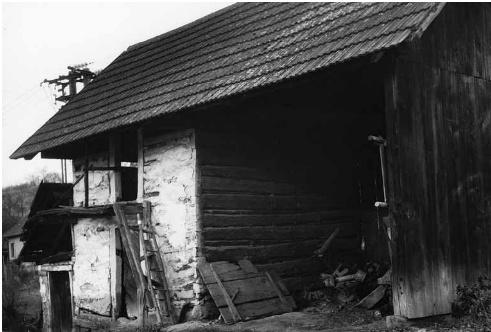
Březnice čp. 21, roubená komora se sklípkem
